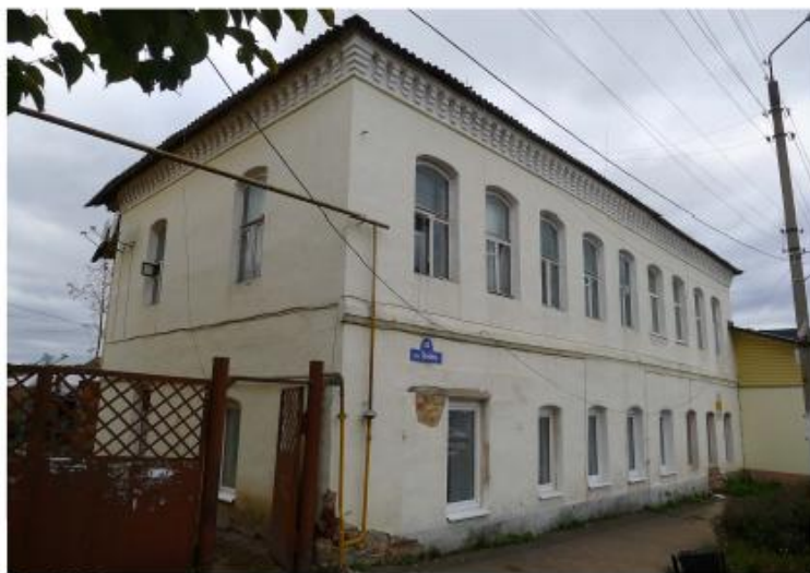
Фото 98. Вид с юго-востока.
