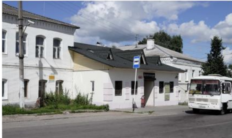
Здание пожарной части (пл. Ленина, 12)
